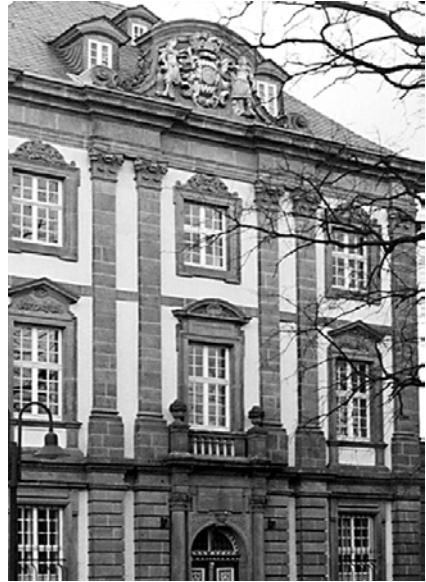
Abb. 13 Front des Ostflügels am Mauritius-Gymnasium (ehem. Jesui- tenkolleg) Büren mit dem Wappen.
