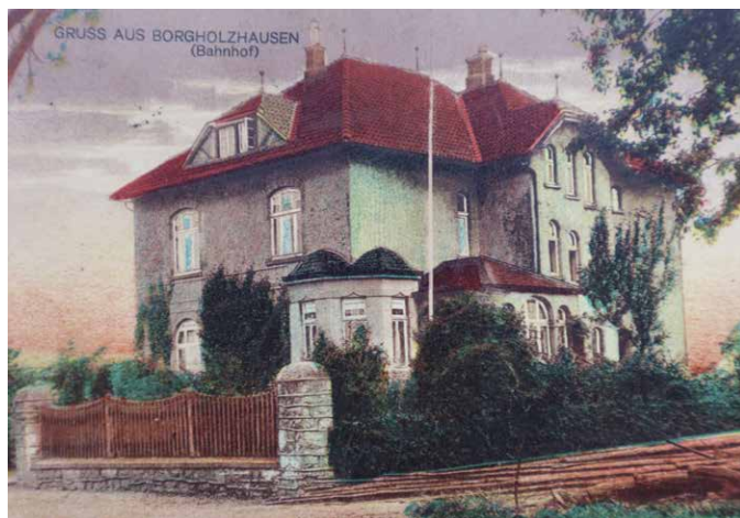
Versmolder Straße 4, erbaut 1908. Foto von Hanna Nollmann
