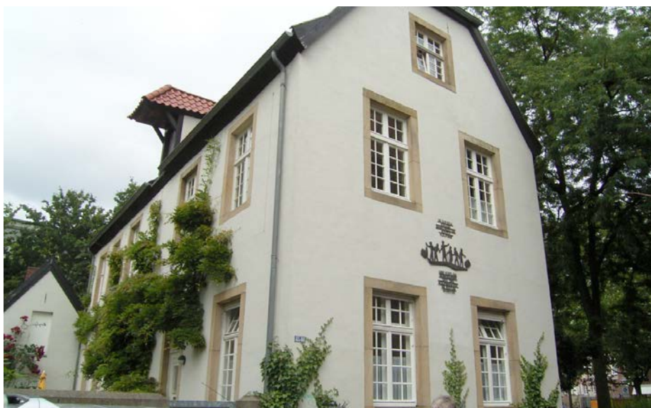
Die Räumlichkeiten im markanten Haus in der Krummen Straße 45 in Münster können nun von Referent:innen der Kolpingjugend und des Kolping-Bildungswerkes genutzt werden.
