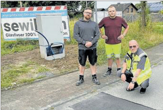
Rückbau der Asphaltfläche in den ursprünglichen Zustand: (v.l.) Kevin und Leon Koch (K & G Hoch- und Tiefbau GmbH) und Jürgen Malsch (Bauleiter Fa. sewikom). Foto: sewikom
