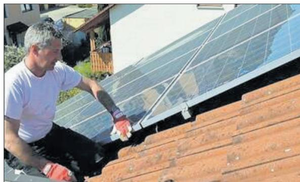
Der qualifizierte Dachdecker prüft die Befestigungen der Solarmodule und begutachtet die Unterkonstruktion im Rahmen des Dach-Checks. Foto: HF Redaktion/akz-o
