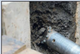
Der Bohrkopf wird hydraulisch horizontal durch den Boden getrieben.
