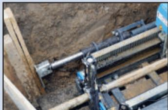
Die Minibohranlage sorgt für eine genau Verlegung des Glasfaser-Hüllrohres.
