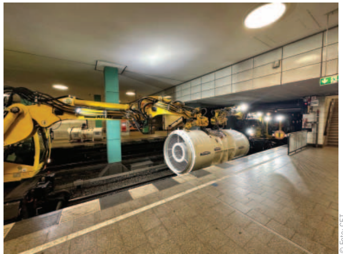
Platzierung eines Ventilators an Ort und Stelle
