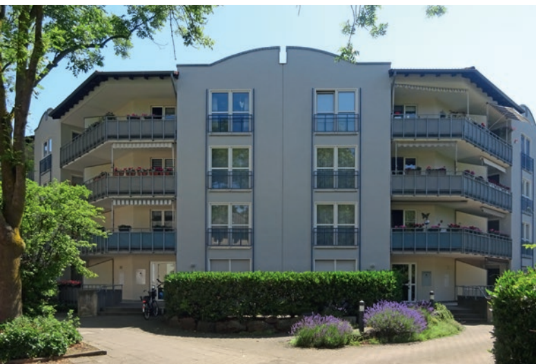
Ein neuer Anstrich für die Fassade an der Vinckestraße 52–54
