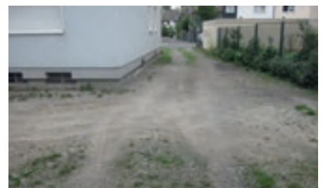
Der alte Schotterbelag ist Geschichte
