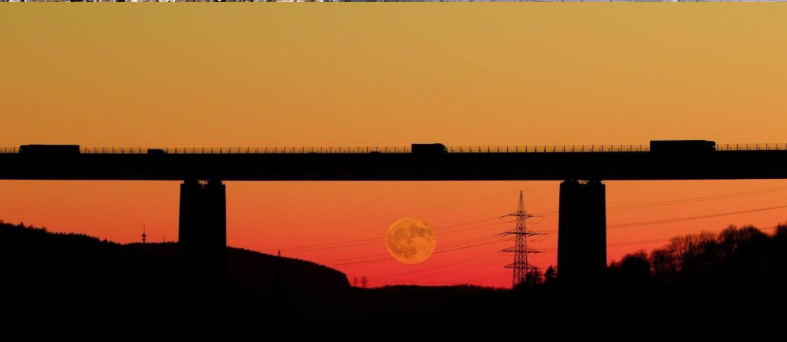
Supermond unter der Siegtalbrücke Foto: Andreas Domian
