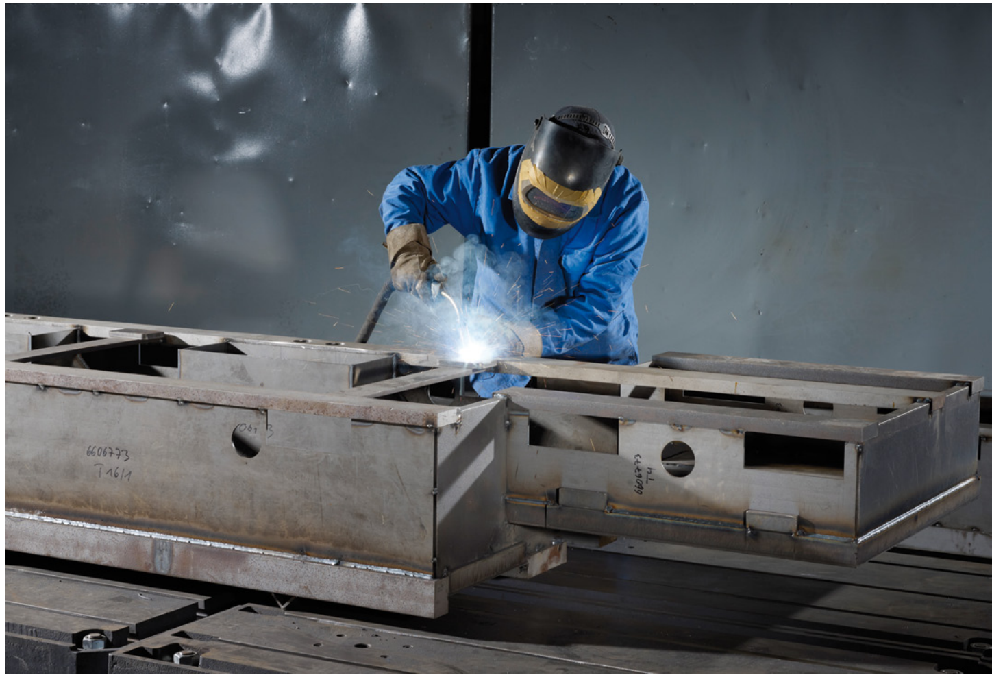
Schweißen der Stahlkonstruktion eines Monolith™-Maschinenbetts
