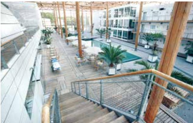
56 Fichtenstämme stützen die 180 Meter lange und 75 Meter breite Glashülle.
