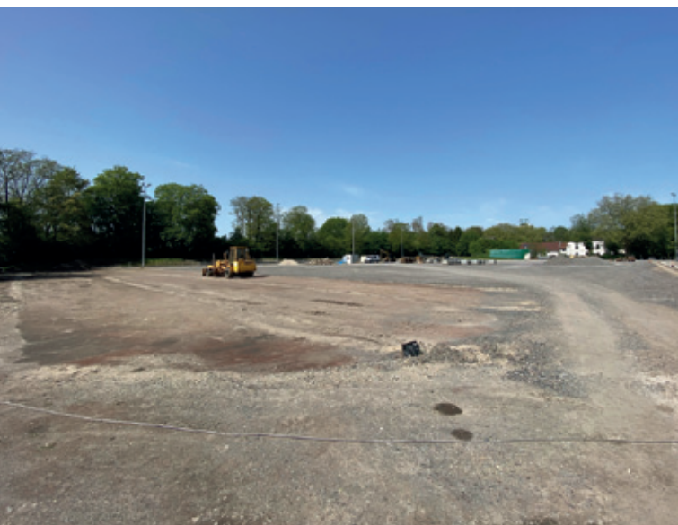
Der Bau der Quartierssportanlage an der Heinrich-Gustav-Straße ist in vollem Gange
