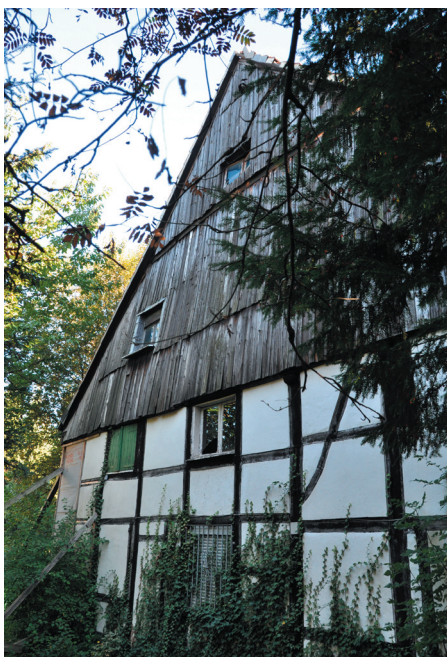
Außenstützen sichern das Haus
