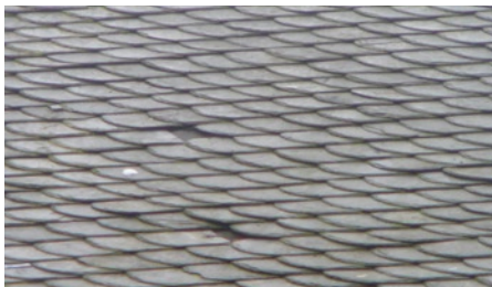
Deutlich erkennbar: beschädigte Schieferplatten
