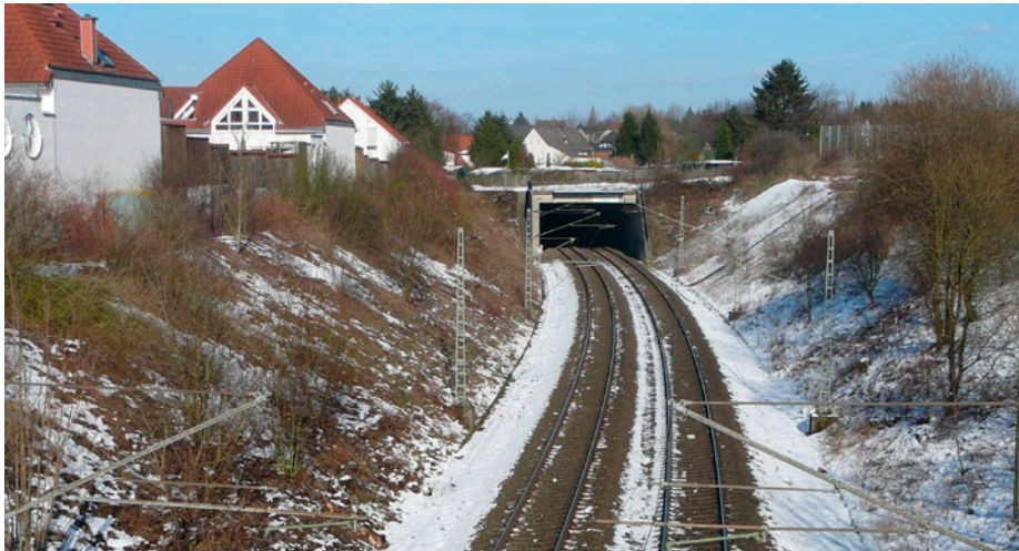
Tunnel und Trasse im Winter 2013, 25 Jahre nach Fertigstellung
