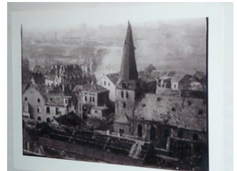
Schwere Beschädigungen an der Christuskirche nach dem Bombenangriff 1944
