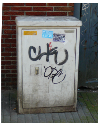
Kasten 8, Alte Bahnhofstr.196 vor Cut
