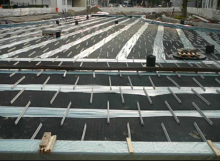
*Filigrane Arbeit - der Einbau des Masse-Feder-Systems unter der Marktkreuzung in Langendreer zur Eindämmung von Vibrationen beim Straßenbahnverkehr*
