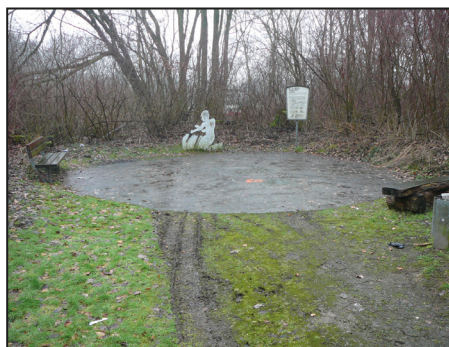
„Mansfeld“-Spuren: Betonplatte über dem verfüllten Schacht 7 an der Urbanusstraße im Papenholz - mit Erinnerungstafel und Sitzbänken
