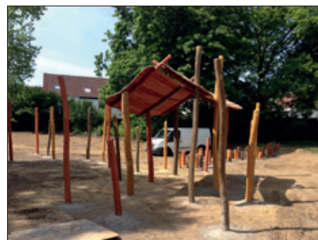
Holzkonstruktionen an der grünen Wegeverbindung
