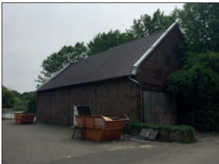
Neues Dach der Festscheune
