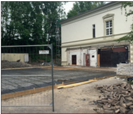
Vorarbeiten für das Fundament der neuen Terrasse
