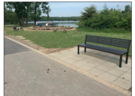
Neue Ruhebänk auf befestigtem Untergrund
