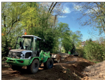
Bauarbeiten an der Wegeverbindung zwischen Werner Friedhof und Wallbaumweg
