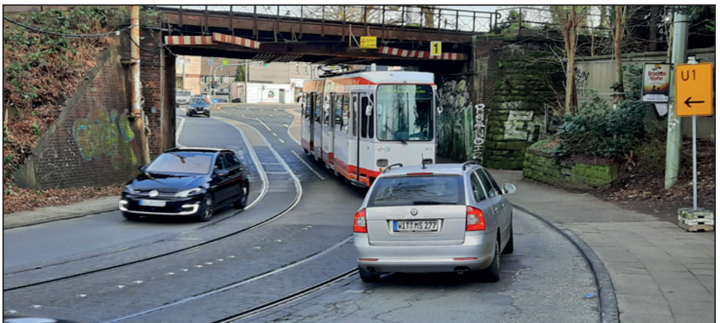
Der Hemmschuh für den zügigen Baufortschritt - die alte Brücke am Crengeldanz in Witten
