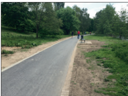
Sanierter Weg am östlichen Ufer...
