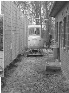
Bagger ersetzt Handarbeit
