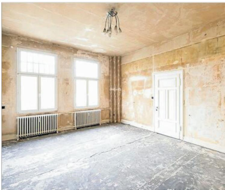
Unebene Wände und sichtbare Installationsleitungen sind bei der Altbausanierung eine Herausforderung. Gipsplatten sind eine unkomplizierte und schnelle Lösung, um die Innenräume zu modernisieren. Foto: Adobe Stock/Robert Pooten/BVGips
