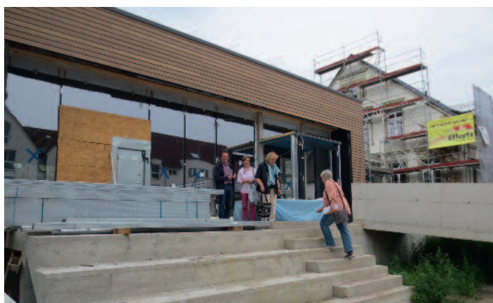
Die Arbeiten am Schnitkerhaus-Anbau gehen gut voran. (Foto: Moritz)
