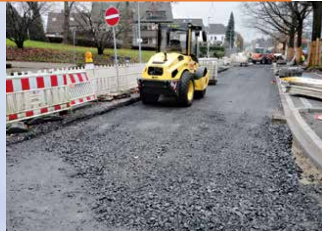
Bald Geschichte: Die Dauerbaustelle am Harpener Hellweg.
