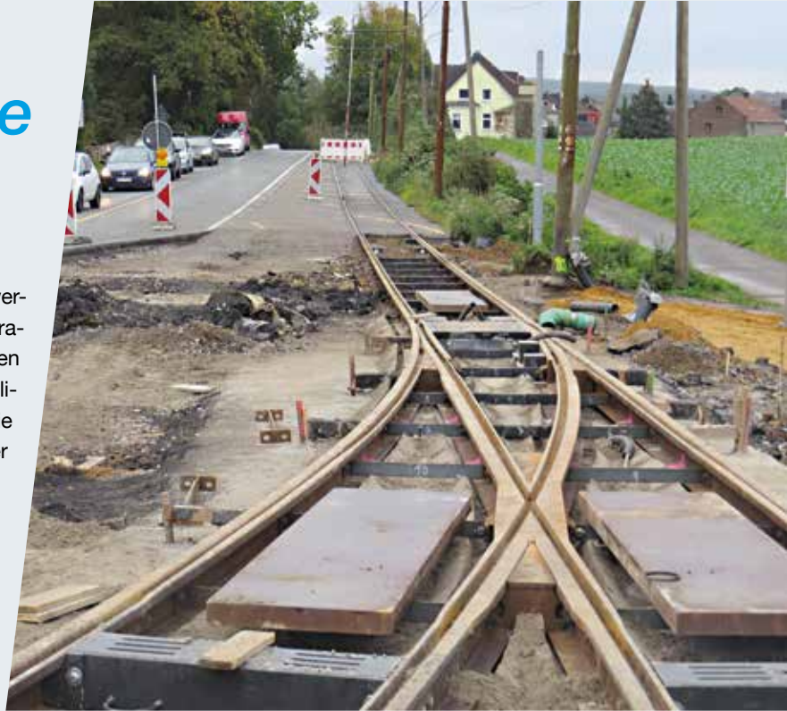
Der Schulterschluss ist da, Witten und Bochum sind mit dem Schienennetzwerk wieder verbunden. Foto: Eberhard Franken
