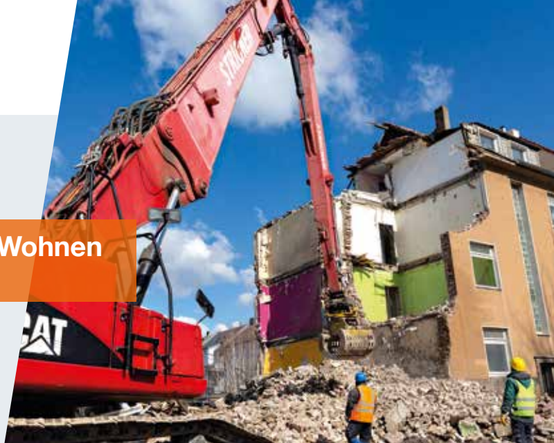
Der Abrißbagger ist angerückt, drei Häuser machen an der Wasserstraße Platz für ein neues, seniorenfreundliches Wohnprojekt. Foto: GWV
