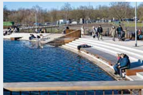
Schon im Januar während der Bauarbeiten wurde der See stark besucht.
