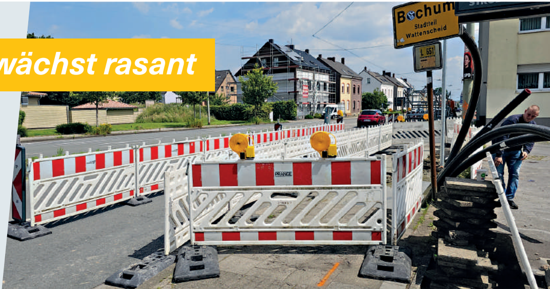
Am Wattenscheider Hellweg liegt nun die Glasfaserleitung.
