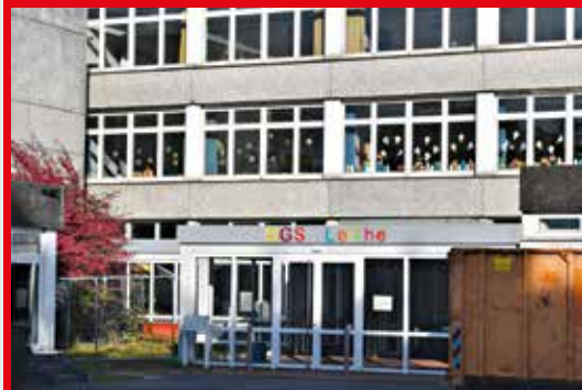
Die Fassade an der Gemeinschaftsgrundschule Leithe soll erneuert werden. Foto: Peter Mohr
