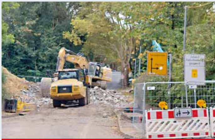
Am ersten Herbstferienwochenende wurde die Brücke an der Parkstraße abgerissen. Foto: Peter Mohr
