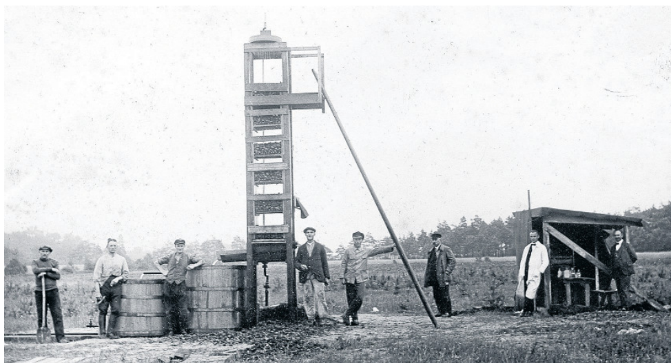
Dauerpumpversuche 1925 am Grevener Damm.
