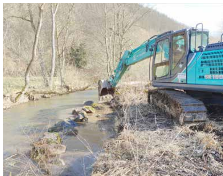
Abbildung 18: Einbringen der alten Ufersicherung als Strömunglenker.
