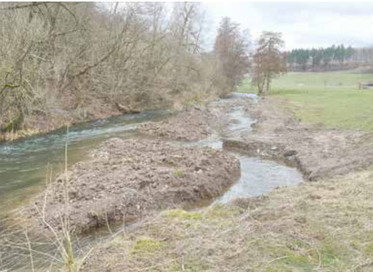
Abbildung 19: Verweigungsgerinne zwei Wochen nach Fertigstellung.
