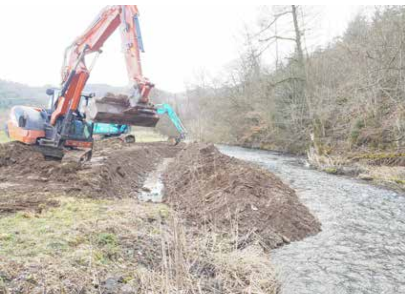
Abbildung 17: Anlage eines Verzweigungsgerinnes.
