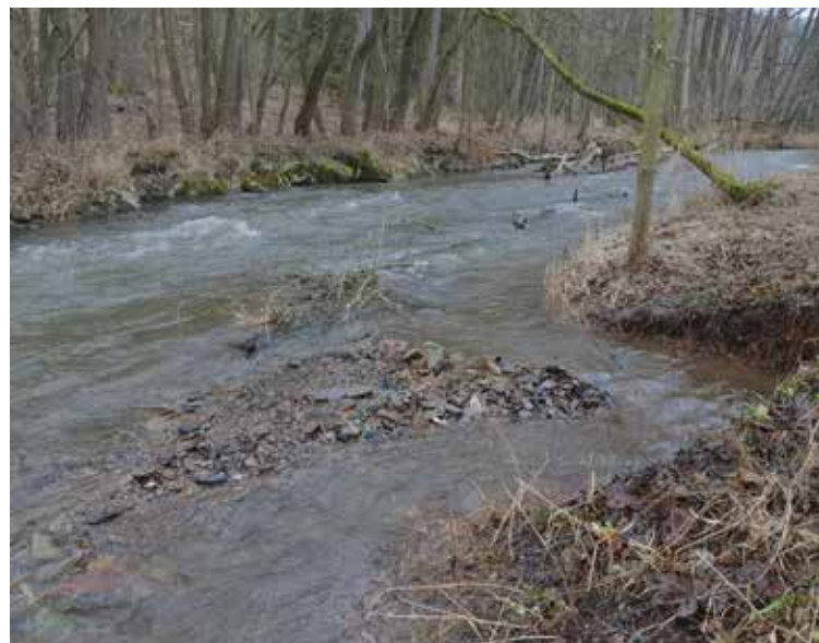
Abbildung 16: Per Hand angelegte Kiesbank unterhalb der Kläranlage Bredelar.
