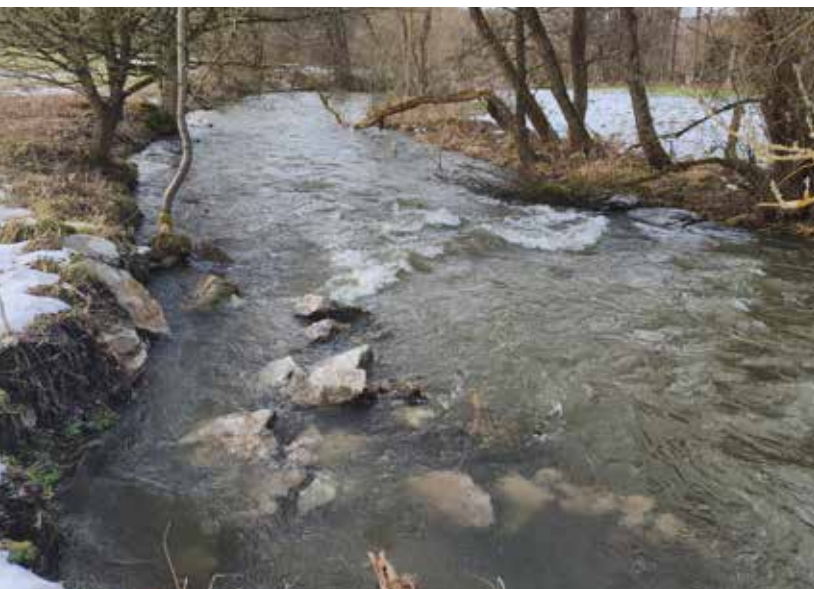
Abbildung 15: Auflösen des Uferverbaus per Hand oberhalb der Kläranlage Bredelar.
