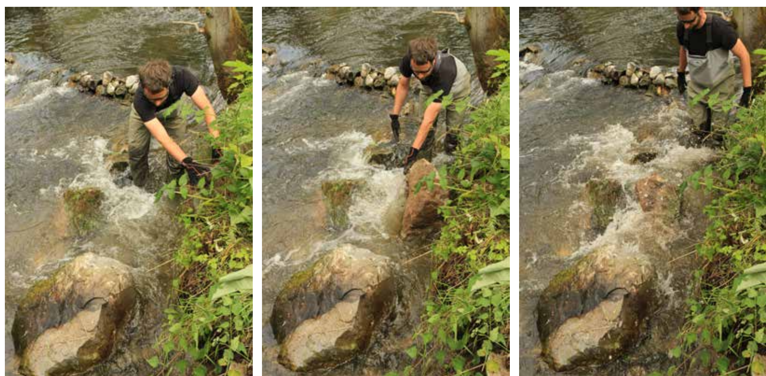
Abbildung 11: Entfernen der Ufersicherung
