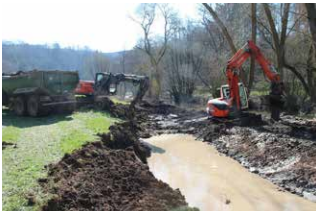
Abbildung 5: Beginn der Maßnahmenumsetzung im März 2020.
