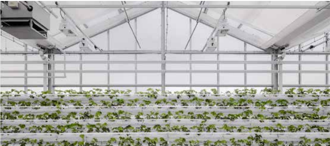
Blick in das Dachgewächshaus: Die Klimatisierung erfolgt durch die Abwärme der Büros des Jobcenters.
