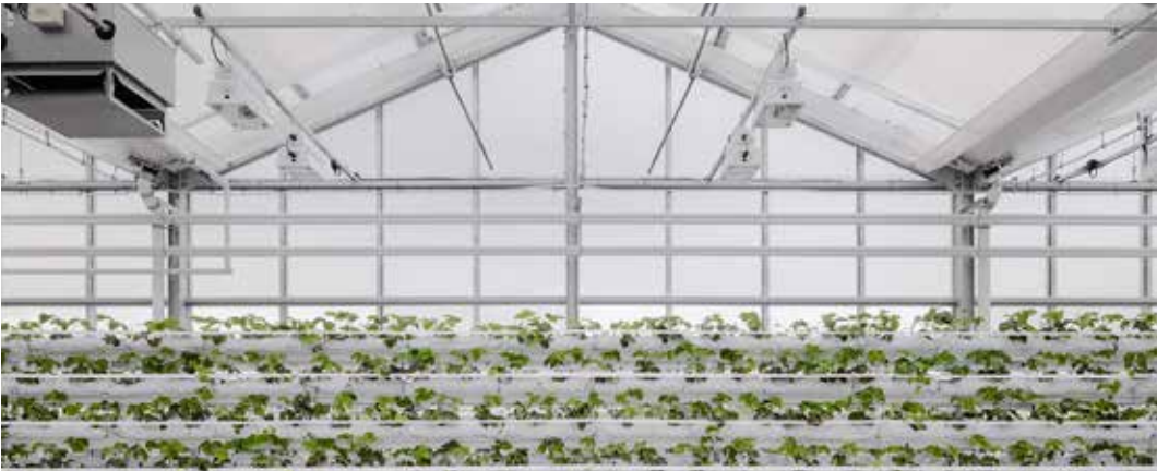
A view of the greenhouse rooftop: Air conditioning is provided by waste heat generated from the job centre offices. Vue de la serre sur le toit : la climatisation est assurée par la chaleur résiduelle des bureaux de l'agence pour l'emploi.
