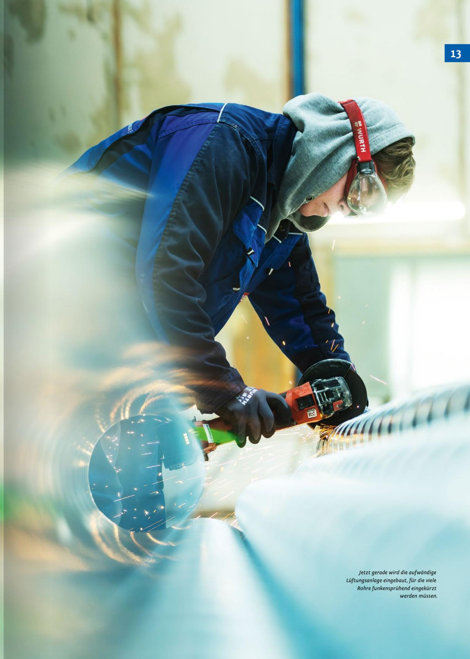
*Jetzt gerade wird die aufwändige Lüftungsanlage eingebaut, für die viele Rohre funkensprühend eingekürzt werden müssen.*
