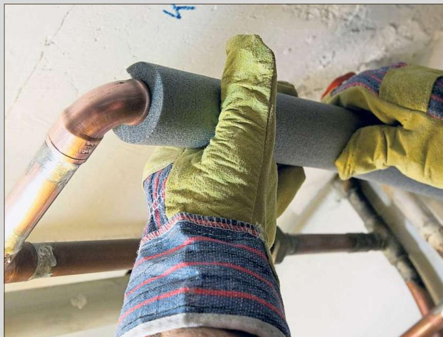
Das Heizungsrohr gibt in unbeheizten Räumen unnötig Wärme ab. Eine Isolierung aus Schaumstoff verhindert das. Foto: dpa
