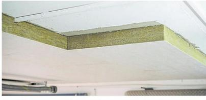
Die Dämmung der Kellerdecke ist eine sehr effiziente Einzelmaßnahme.
