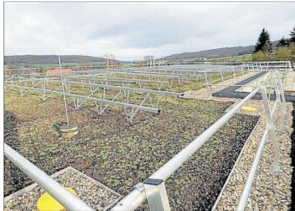
Die sanierte Dachfläche mit Gründach und neuem Entwässerungssystem sowie der Unterkonstruktion für die PV-Anlage.
