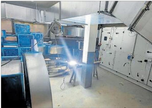
Die zentrale Be- und Entlüftungsanlage mit Wärmerückgewinnung und Kühlfunktion im Erdgeschoss.
