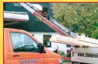
Hand in Hand haben die Handwerker Großartiges geleistet.
