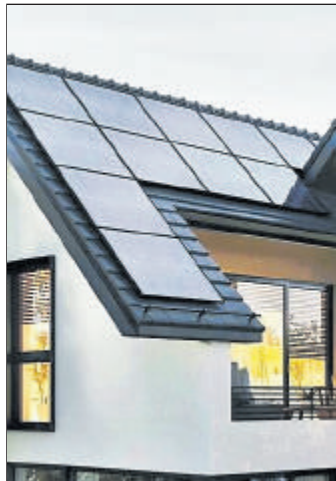
Dach und Photovoltaik, beides braucht Pflege Foto: slavun 2/stock.adobe.com/akz-o
