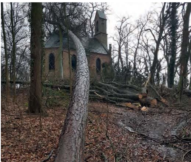
Sturmschäden an der Meinolfus-Kapelle im Wilhelmsberg
