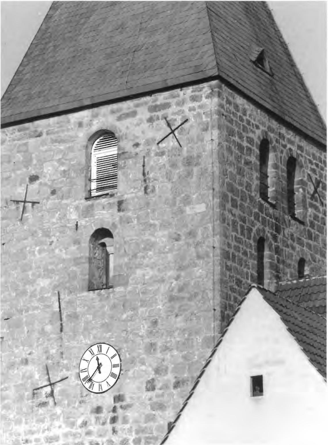
Abb. 3 Der aus der 1. Hälfte des 13. Jahrhunderts stammende Turm der Kirche in Detmold-Heiligenkirchen. Er wurde nach schweren Schäden durch das Erdbeben vom 19. Januar 1767 auf allen vier Seiten mittels eiserner Klammern und Stabilisierungskreuze instandgesetzt. Foto F. Devermann, Lipp. Landesmuseum Detmold.
