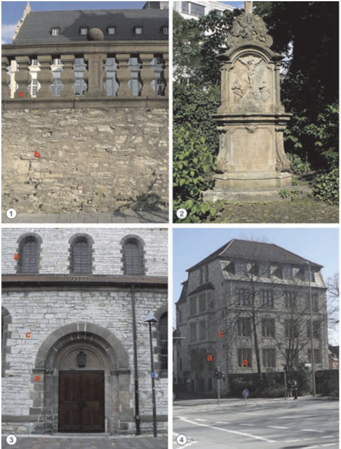
Abb. 44: Rütthener Grünsandstein in Paderborn. 1 Ehem. Jesuitenkirche St. Franz Xaver, 1682 - 1692 Einfriedung des Vorplatzes; 2 Bildstock am Paderwall, 1745; 3 Kath. Kirche St. Ulrich, sog. Gaukirche, um 1170/1180 restauriert 1883 - 1887, 4 Busdorfwall 2 (Stadtarchäologie Paderborn) Anfang 20. Jh.; a Rütthener Grünsandstein, b Plänerkalksteine der Erwitte-Formation, obere Plänerkalkstein-Einheit; c Plänerkalksteine der Salder-Frmation.
