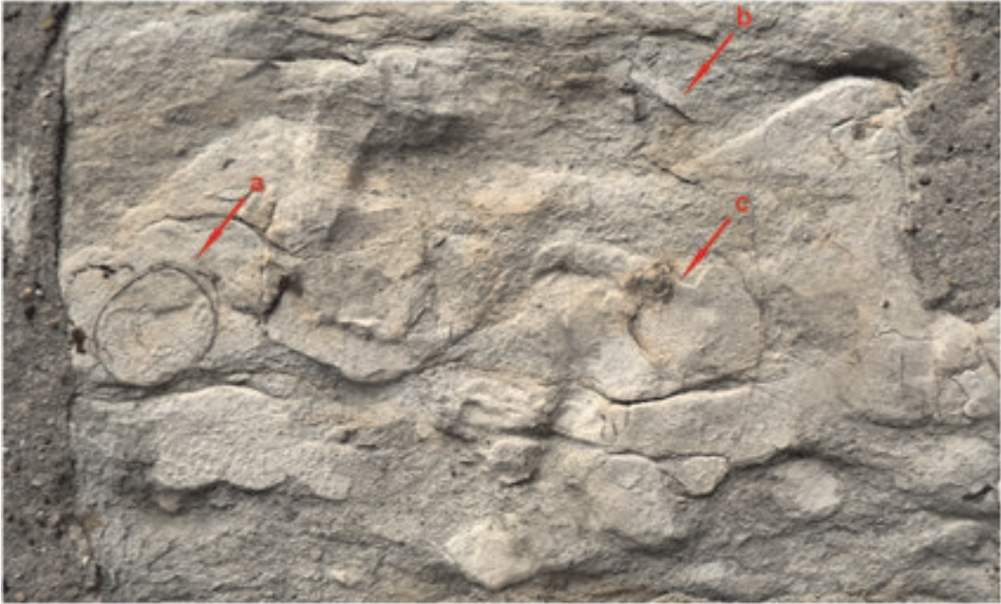
Abb. 35: Paderborn, Westseite der Gaukirche St. Ulrich, kompakter Plänerkalkstein der Salder-Formation, Oberuronium mit typischer Fauna aus a dünnchaligem Sternotaxis sp., b feinscherbigem Inoceramenfragmenten und c kleinem Schwammfragment.
