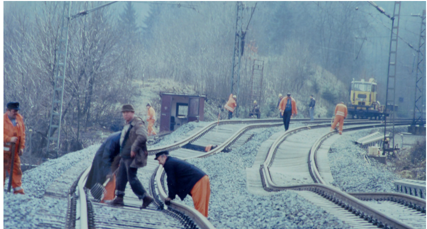
Abb. 5: Verschobene und verbogene Gleise nach Hangrutschungen am Paderborner Berg zwischen Neuenheerse und Willebadessen (Foto: Heinrich Glitz, 1988).
