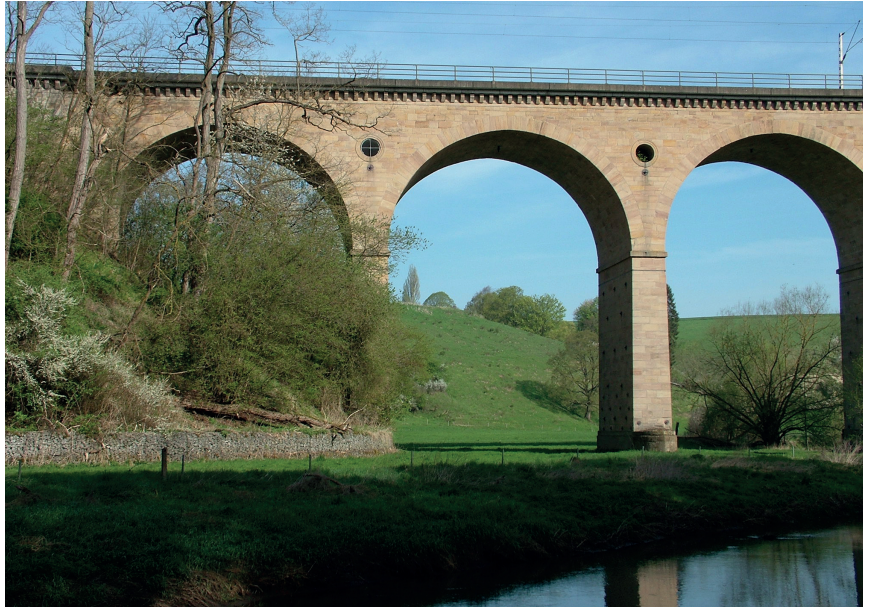
Abb. 6: Der Diemel-Viadukt bei Hueda – errichtet aus Sandsteinen des Mittleren Buntsandsteins (Foto: April 2018).
