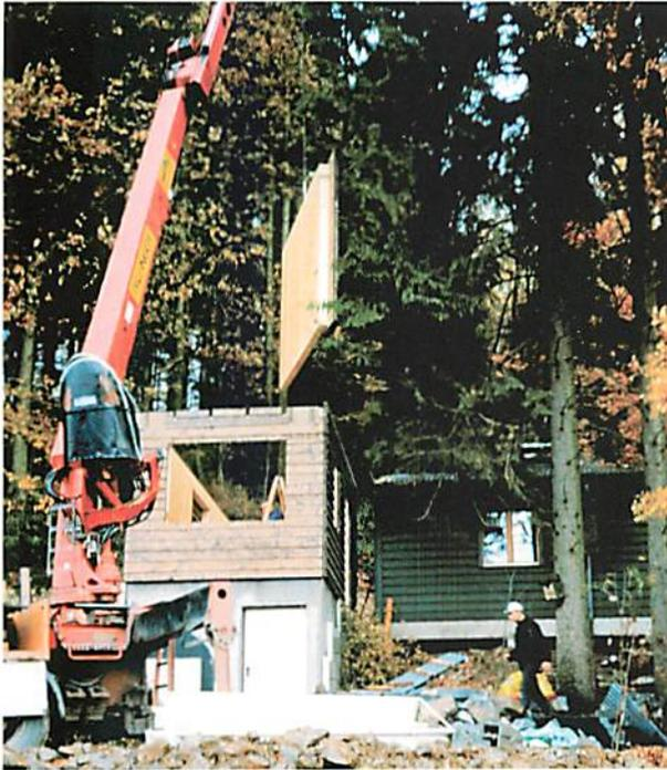
*Genauso schnell wie der Keller entstand, wird jetzt das Erdgeschoss durch Zimmerei Hoff aufgestellt.*
