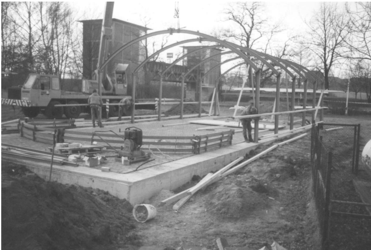
**Auf dem Weg zum Richtfest: Mit einem Autokran wurden die Stahlprofile der neuen Bootshalle aufgestellt und anschließend im Beton verschraubt.**
