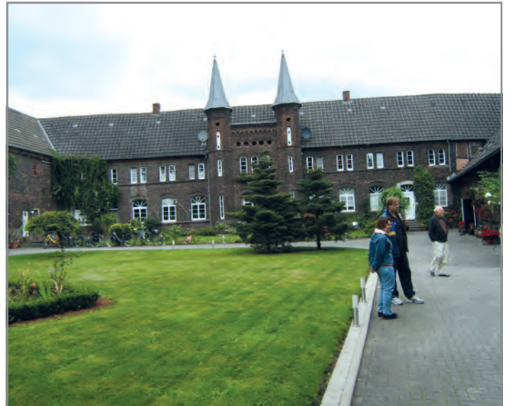
Innenhof der Vorburg 2009
