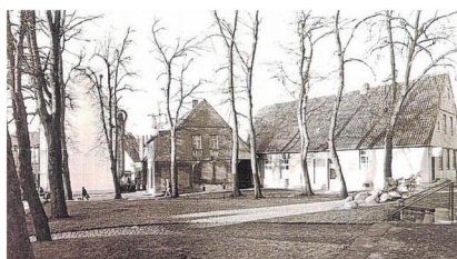
Die Häuser an der Kanalstraße im Jahr 1972.
