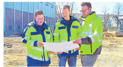
SWTE-Projektleiter Mathias Walke (r.) und seine Kollegen Andre Schröder (l.) und Michael Gilhaus, die sich nach Fertigstellung um das Wärmenetz und die Hausanschlüsse kümmern, verschaffen sich vor Ort einen Überblick über die Bauarbeiten. Foto: Stadtwerke Tecklenburger Land
