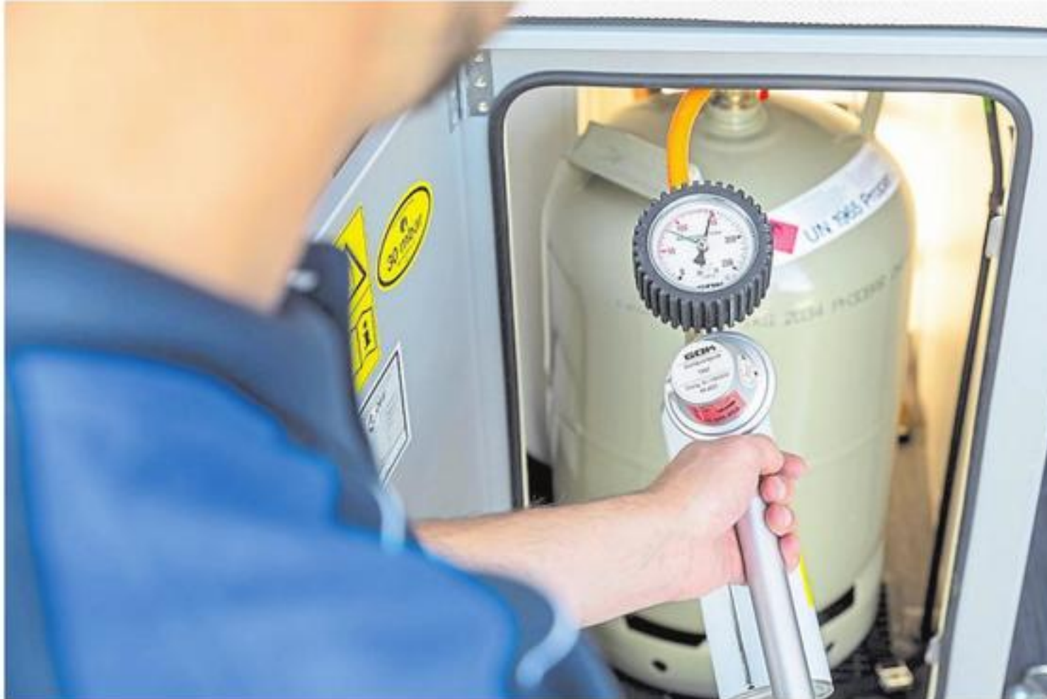
Regelmäßige Gasprüfung für Wohnmobile und Wohnwagen sind ab dem 19. Juni 2025 gesetzlich vorgeschrieben. Foto: TÜV Nord/Julius Sommer
