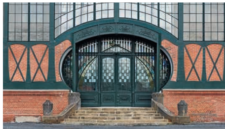
Portal der Maschinenhalle auf Zeche Zollern (Foto: CEphoto, Uwe Aranas / CC-BY-SA-3.0)
