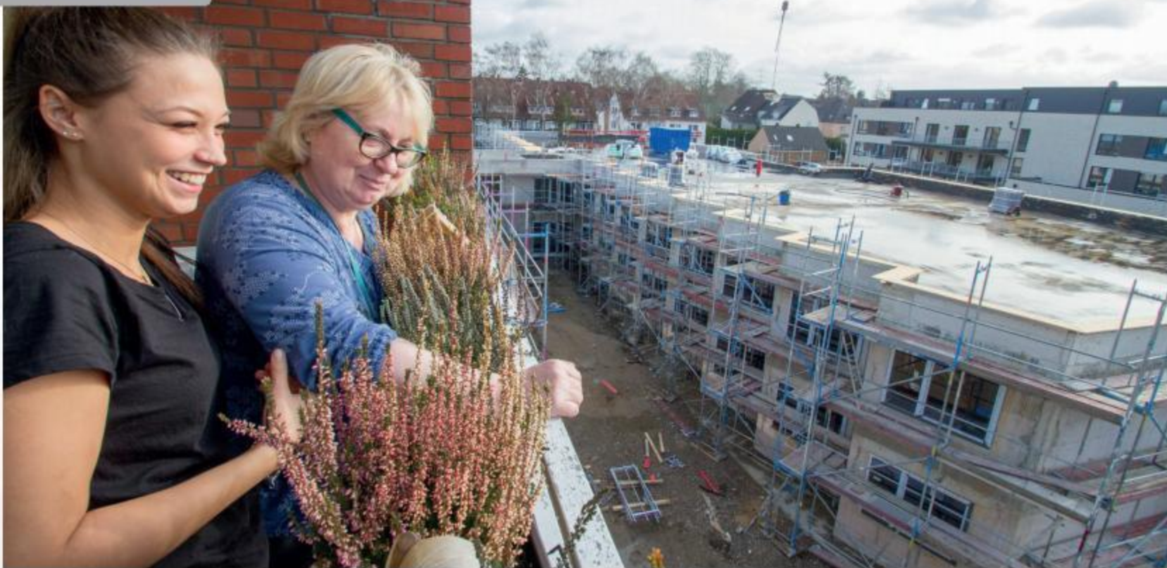
Auszubildende Nadine Grelewicz und Bewohnerin Monika Jaeschke blicken vom 4. Stock auf die Baustelle des Neubaus.
