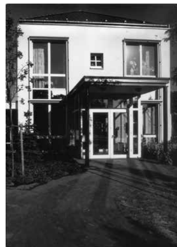
Die Kita am Wöstmannsweg wurde 1992 als achte städtische Tageseinrichtung eröffnet. (Bild: Stadtarchiv Gütersloh)
