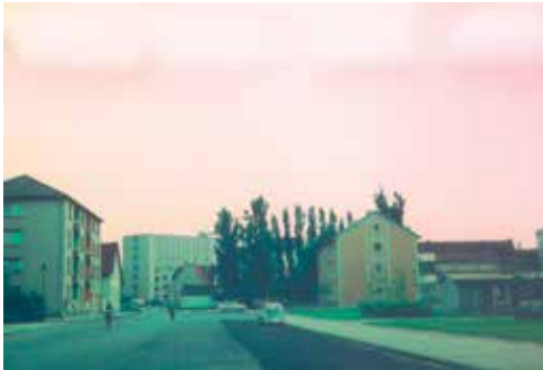
Die Friedrich-Ebert-Straße (damals noch „Blücherstraße“) vor dem großen Bauboom der 1960er Jahre. Der erste Teil des neuen Rathauses ist aber bereits fertig. (Bild: Stadtarchiv Gütersloh)
