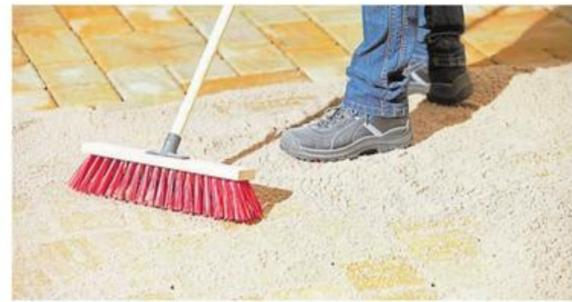
Die innovativen Produkte werden trocken in die Fuge eingefegt und punkten mit einem einfachen Handling. Foto: HLC/Buschbeck
